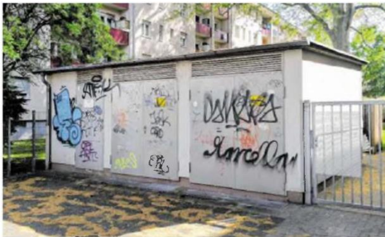
Vorher: die Trafo-Station der MVV Energie in F 6, 6. Das graue und beschmierte Gebäude bietet Graffiti-Künstlern viel Fläche.
